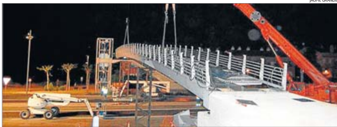
Operació d'instal·lació de les peces que formen la plataforma de passarel·la durant la matinada de dimarts
