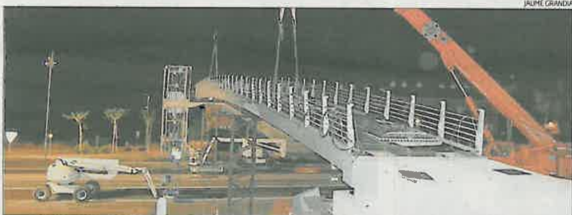
Operació d'instal·lació de les peces que formen la plataforma de passarel·la durant la matinalada de dimarts
